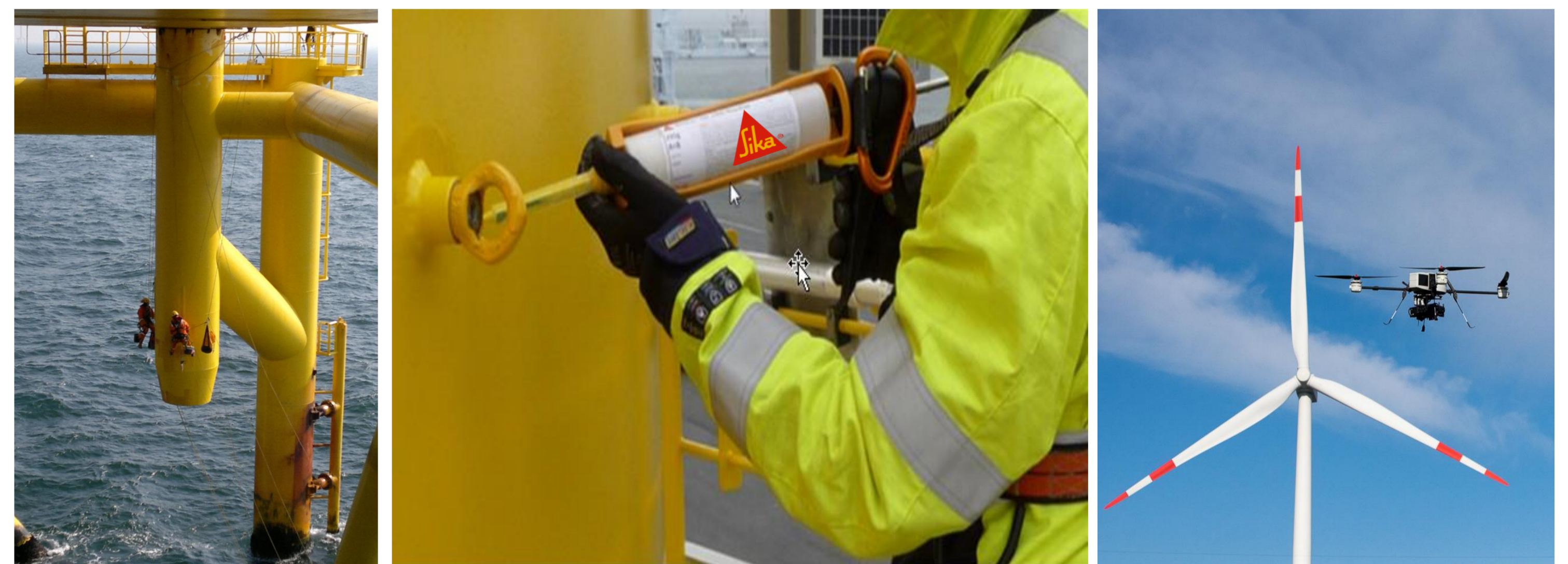
Inspektion/Reparatur einer OWEA-Anlage und Drohnentechnik (Quellen: Muehlhan AG, Sika GmbH, IFAM)
